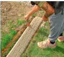
Auch das ist Handarbeit. Nun stechen wir die Dehnfugen, so dass auch bei Frost die Leiste nicht brechen kann.
