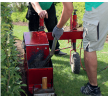
Die Randleistenmaschine kompaktiert den Spezialbeton und legt die Rohleiste in die Erdaushhebung.
